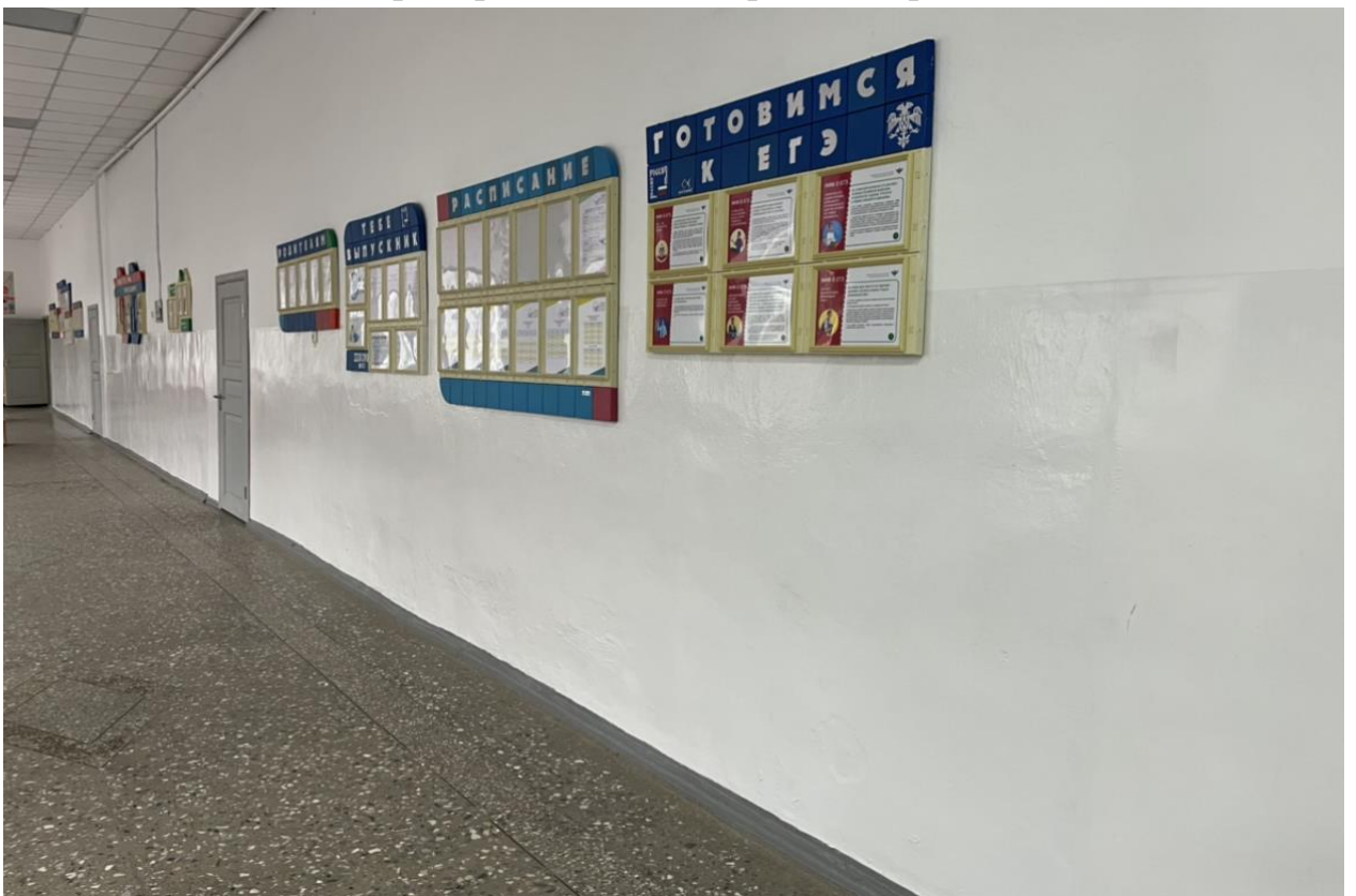
Коридор школы после замены дверей и покраски стен в белый цвет.
